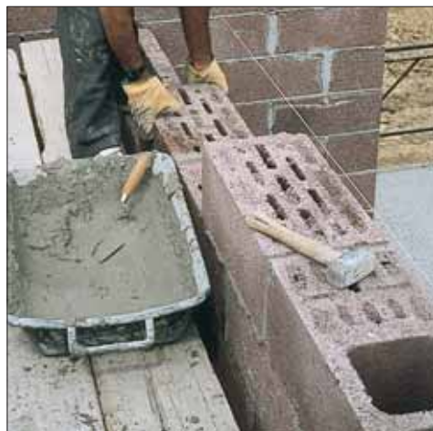
Posa di muratura armata in Lecablocco.
