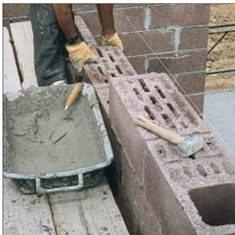
Posa di muratura armata in Lecablocco.
