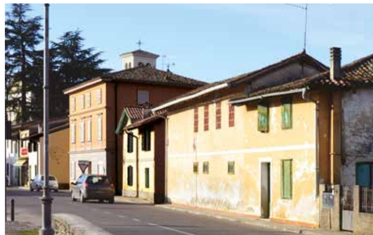
Comparto edilizio preesistente - prima della demolizione
