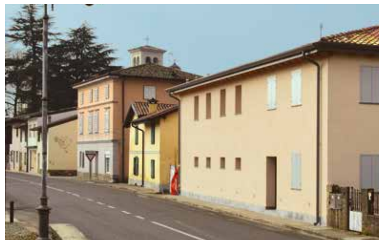
Ricostruzione dell'edificio residenziale in seguito alla demolizione.
