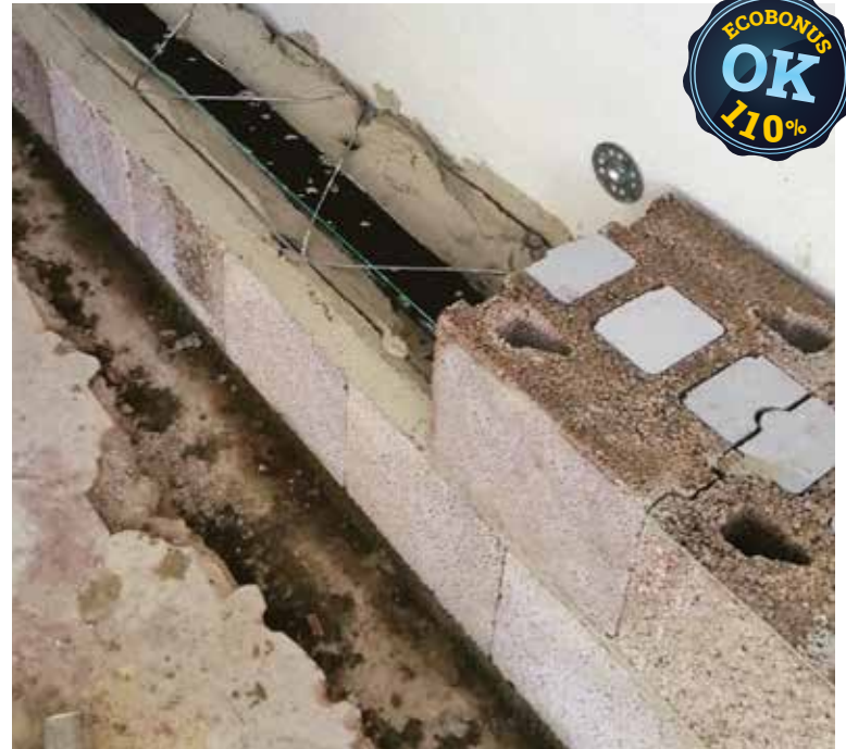
La parete in Lecablocco Bioclima Zero29T è stata posata con Malta Leca M5 Supertermica per ottimizzare il comportamento della parete, con striscia isolante e traliccio metallico.
