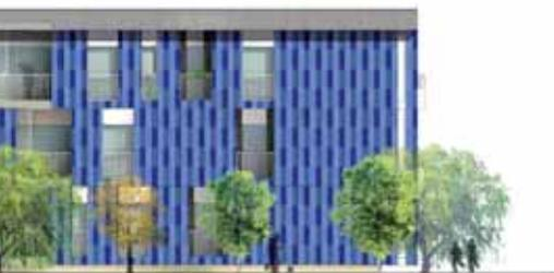
Edifici E.R.P. con involucro esterno realizzato con Leca-blocco Bioclima Zero27T/S rivestito con facciata ventilata in gres porcellanato.
