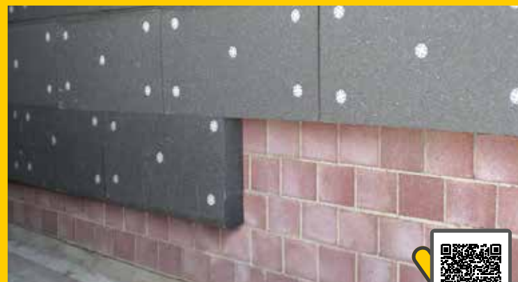
Esempio di parete in Lecablocco Fonoisolante con isolamento a cappotto.
