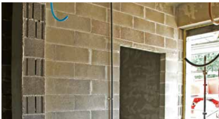
Esempio di parete in Lecablocco Fonoisolante con isolamento a cappotto.
