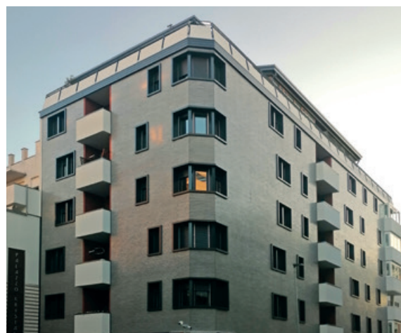
Vista dell'edificio PRIMA e DOPO l'intervento con Murocappotto Design.
